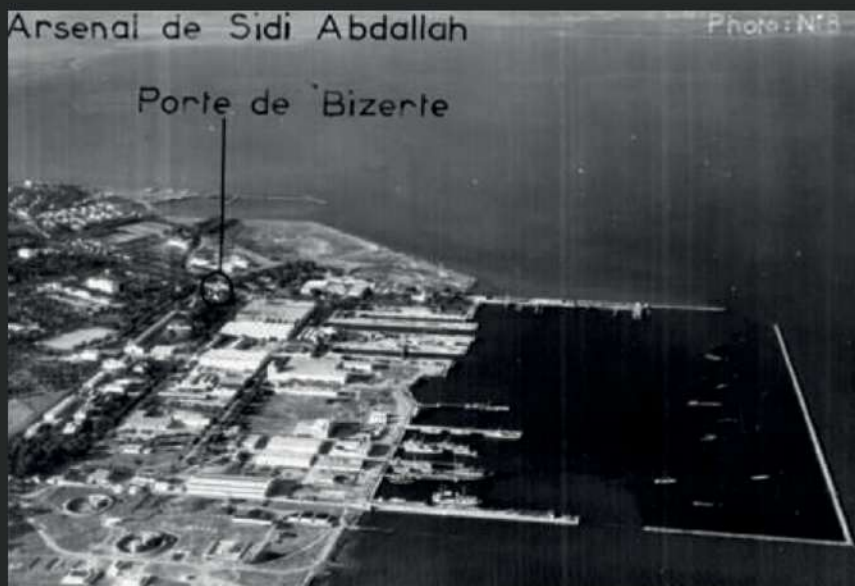
Vue aérienne de la base, zone A, JMO de la 1 re BRG.
