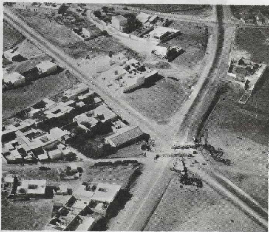
Barrage tunisien sur la route du Nader
