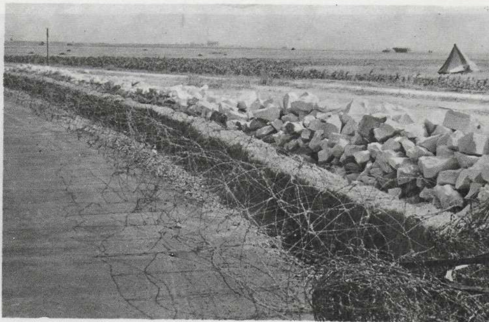
Le 29 Juin des Tunisiens entreprennent la construction d'un mur de pierres à la limite des barbelés dans l'axe de la piste de Sidi-Ahmed.
