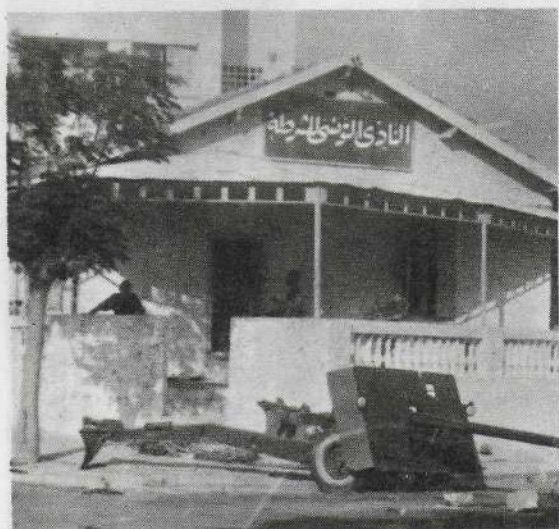
Canon mis en batterie par les tunisiens Avenue Bourguiba
