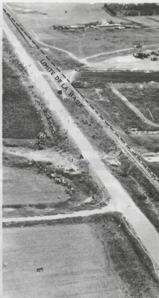
Le 4. Juillet 1500 volontaires tunisiens commencent à creuser des tranchées à quelques mètres de nos barbelés le long de la route qui suit la limite ouest de la Base.
